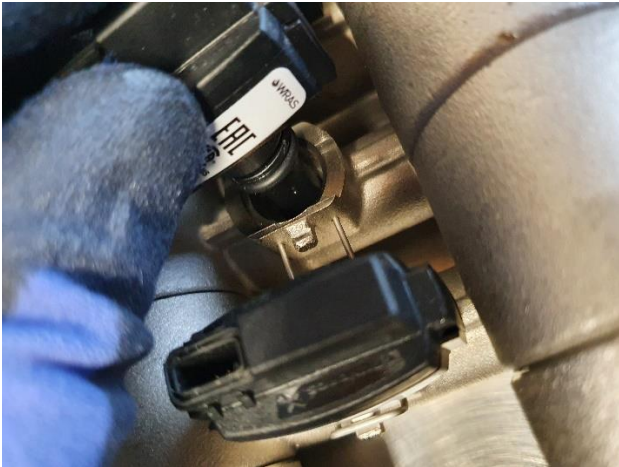
7. Insira o sensor suavemente na tubulação.
