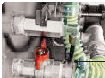
Rubinetto by-pass e rubinetto pompa chiusi
