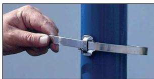
Schlaufe mit den Ohren zum Bandende auf das Band ziehen. Schelle formen und Band auf Band legen. Schlaufe über beide Bänder ziehen und das Bandende ca. 30 mm unter die Schlaufe biegen. Bei hoher Belastung der Schelle (z. B. bei Schlauchbefestigung) Band zweimal durch die Schlaufe ziehen.
